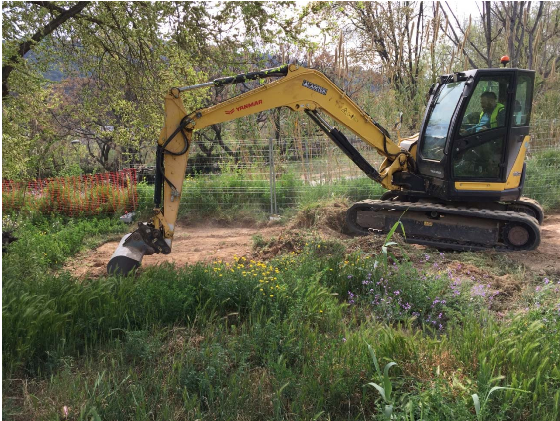
Imatge 9: màquina desbrossant i rebaixant la part baixa del camí.
