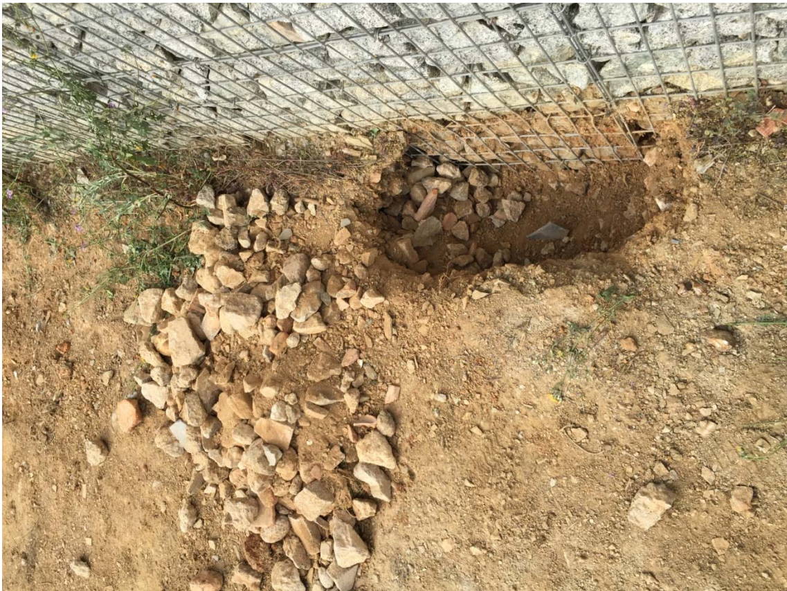
Imatge 16: estrat d'aportació antròpica ple de restes de material constructiu.
