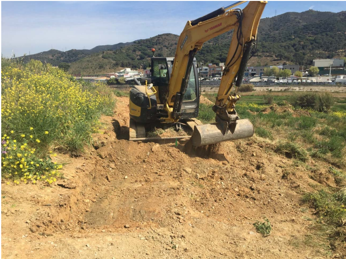
Imatge 11: màquina rebaixant la part baixa del camí.
