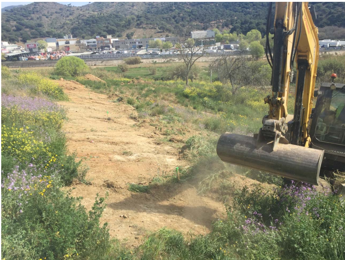
Imatge 10: màquina desbrossant la part mitja del camí.
