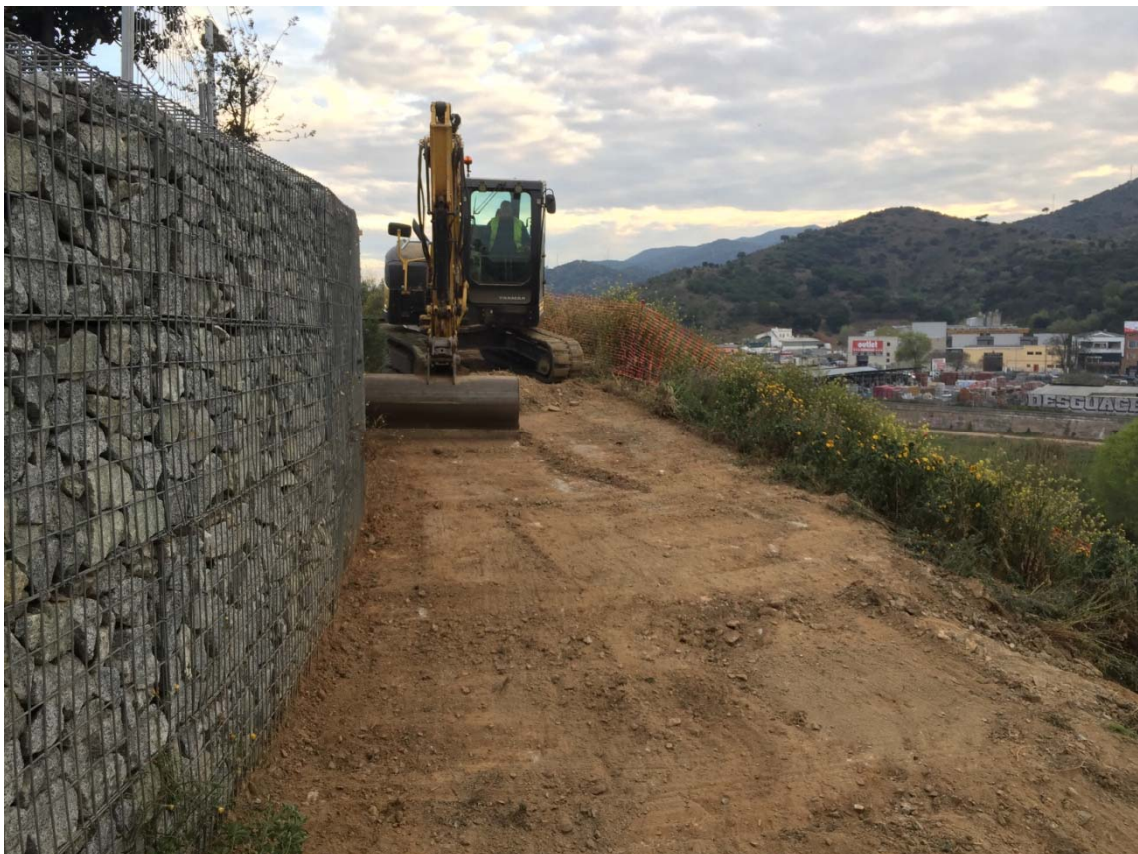
Imatge 12: màquina desbrossant i rebaixant la part alta del camí.
